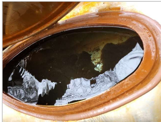
Figure 4 – Vue à l'intérieur du réseau de 500 GUS
