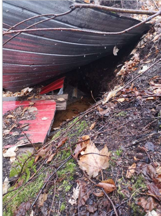
Figure 2 – Ouvrage de captage d'eau
