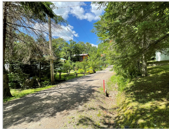
Figure 8 – Vue de l'extrémité nord de la rue du Domaine François vers le régulateur de débit
