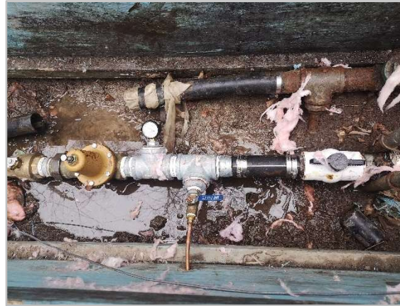
Figure 6 – Régulateur de débit et manomètre
